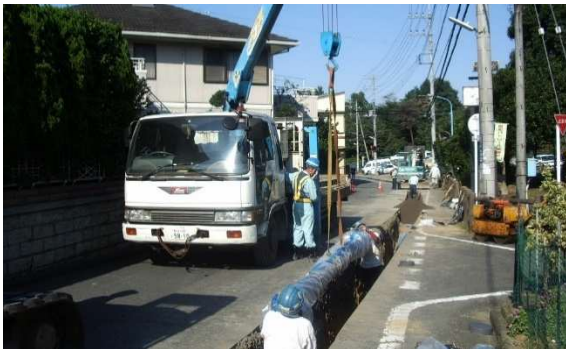
配水本管布設工事
