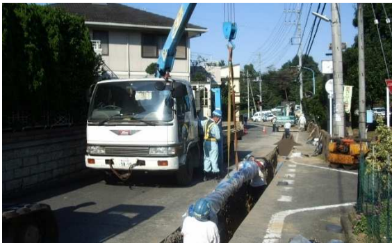
配水本管布設工事
