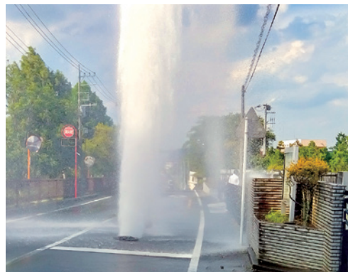
老朽管の破損による漏水の様子 (近隣事業体提供写真)
