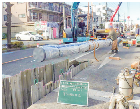
配水本管布設替工事の様子
