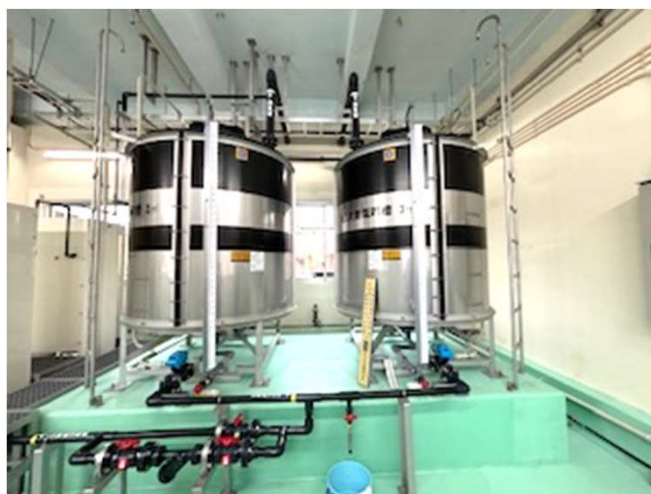
坂戸浄水場次亜注入設備更新工事
