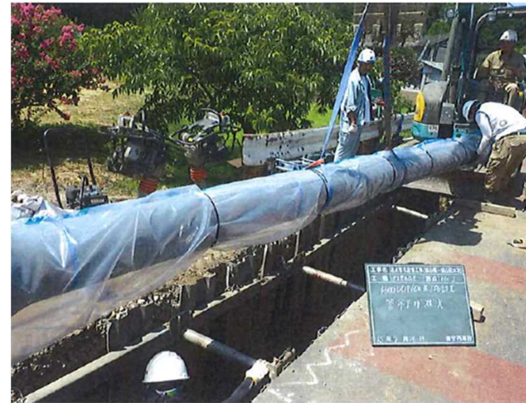
送水管布設替工事（城山橋～城山配水池）
