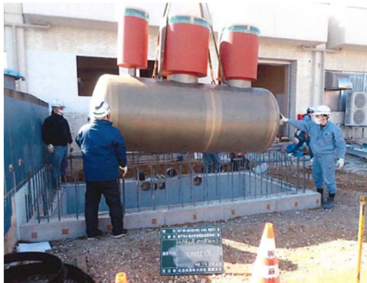
坂戸浄水場自家発電設備更新等工事
