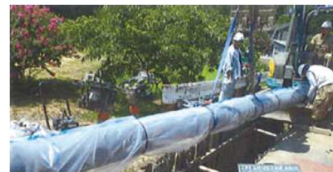
管路の布設替工事の様子 (税込)
