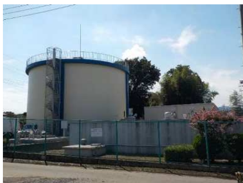
多和目配水場外観
