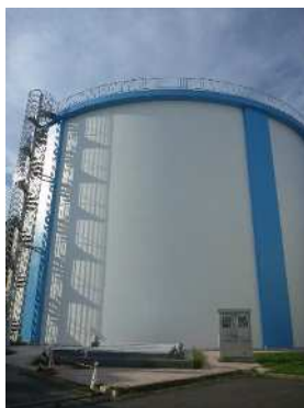
鶴ヶ島 P C 配水池
