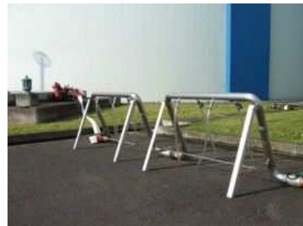
図 4-31 非常用仮設給水栓
