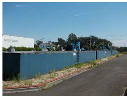
坂戸 R C 配水池
