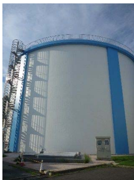
鶴ヶ島 P C 配水池
