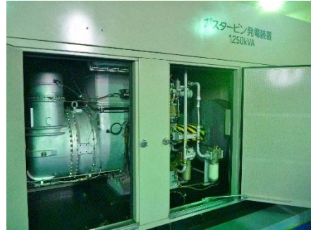
図 4-29 鶴ヶ島浄水場 非常用自家発電機
