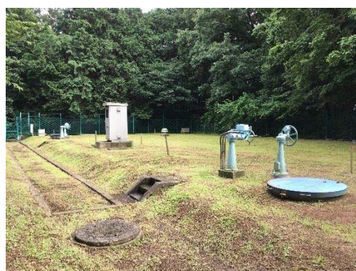
城山配水池外観
