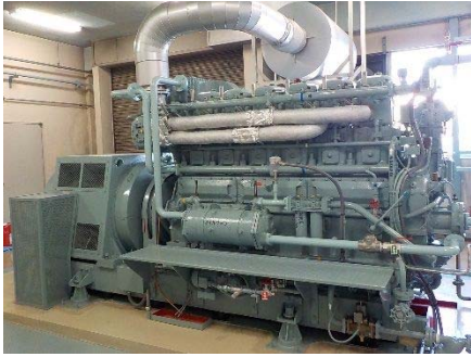
図 4-28 坂戸浄水場 非常用自家発電機
