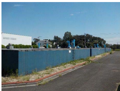
坂戸 R C 配水池
