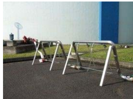
図 4-31 非常用仮設給水栓
