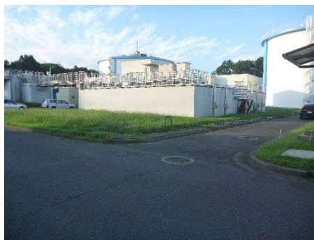
鶴ヶ島浄水場内部
