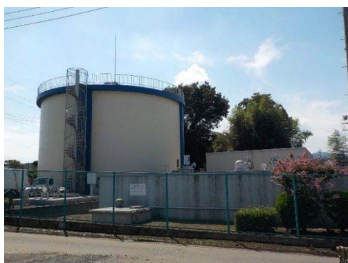
多和目配水場外観
