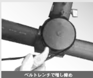
ベルトレンチで増し締め
