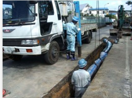
管路の更新工事
