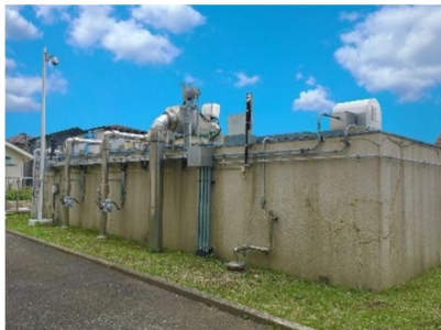
厚川取水中継ポンプ場：井戸からくみ上げた原水を、鶴ヶ島浄水場へ送る施設です。
