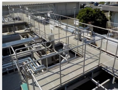
坂戸浄水場除鉄除マンガン装置
