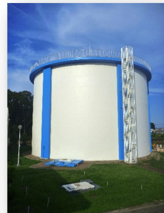
鶴ヶ島浄水場PC配水池
