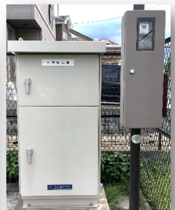
水質遠方監視装置
