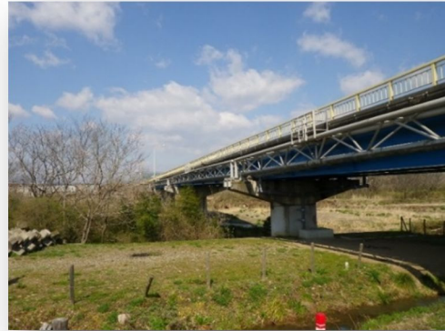
万年橋の水管橋
