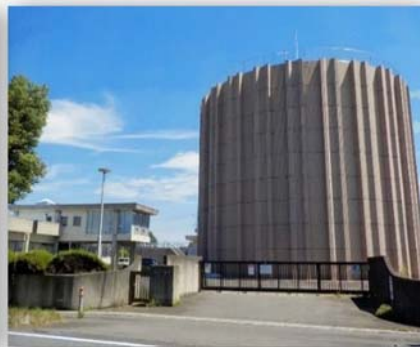
写真3 坂戸浄水場外観
