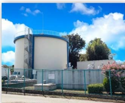
写真1 多和目配水場外観
